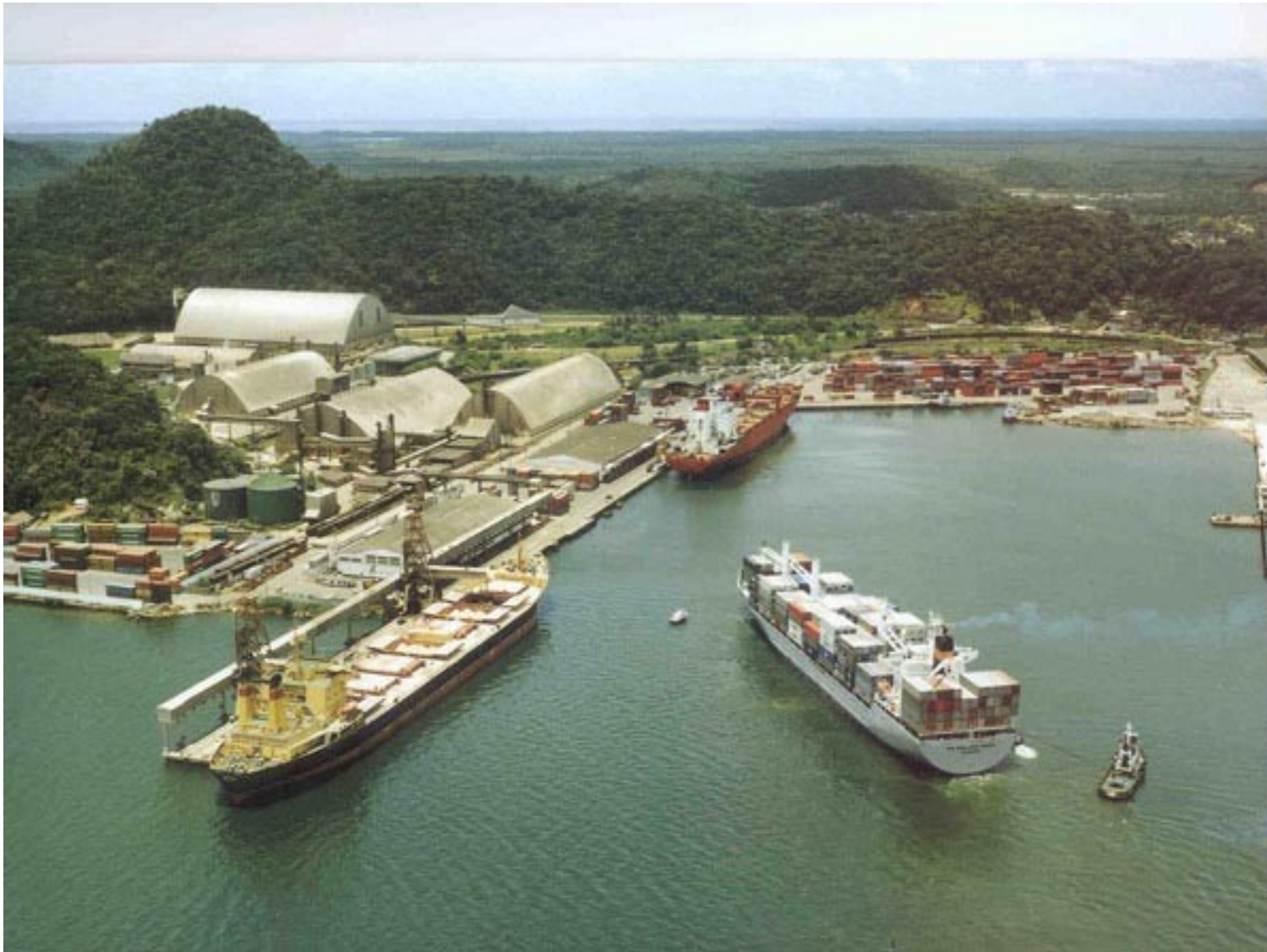
Porto de São Francisco do Sul - SC
