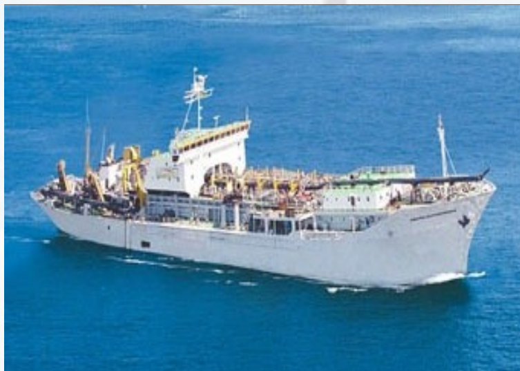
Draga-navio autotransportadora “Copacabana” - 5.000 m 3 . Mais moderna draga em operação no Brasil, construída em 1993.
